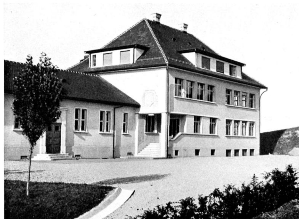
Das Schulhaus Rotkreuz: Ansicht von Süden
