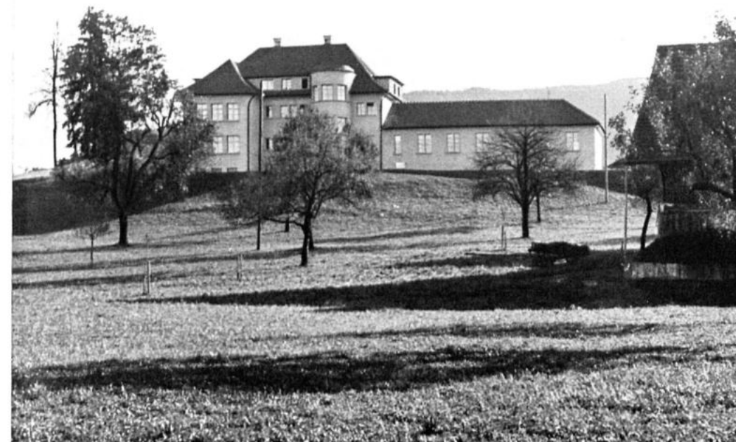
Das Schulhaus Rotkreuz: Ansicht von der Bahnstation aus.
