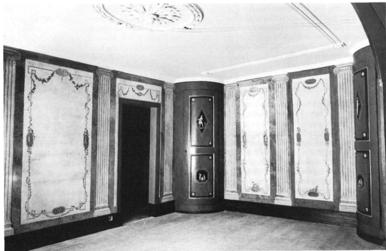
Das Nordzimmer des dritten Stocks mit Blick auf die Ost- und Südwall mit versetztem Eingang. Zustand nach der Restaurierung und der Rekonstruktion der rechten Hälfte der Südwall.
