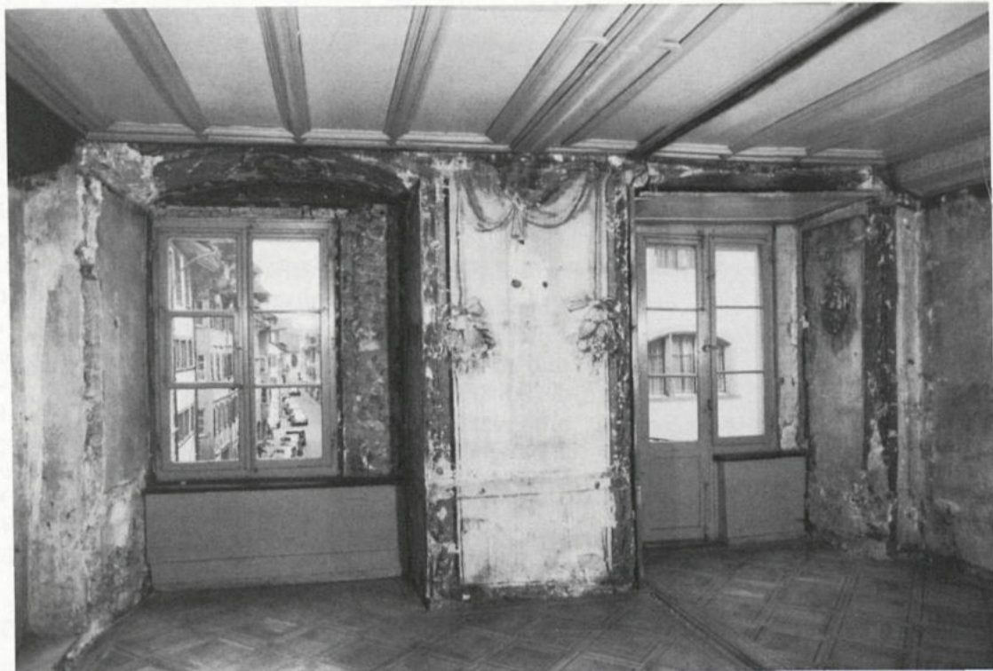
Bemalte Fensterfront im Südzimmer des zweiten Stocks. Zustand nach einer ersten Freilegung.
