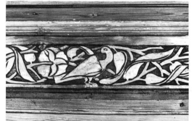
Weitere Details dieser Flachschnitzereien an der gleichen Wand (Brett Nordost) im Südzimmer des zweiten Stocks. Zustand nach der Reinigung. Fotos: Schwarz und Spillmann
