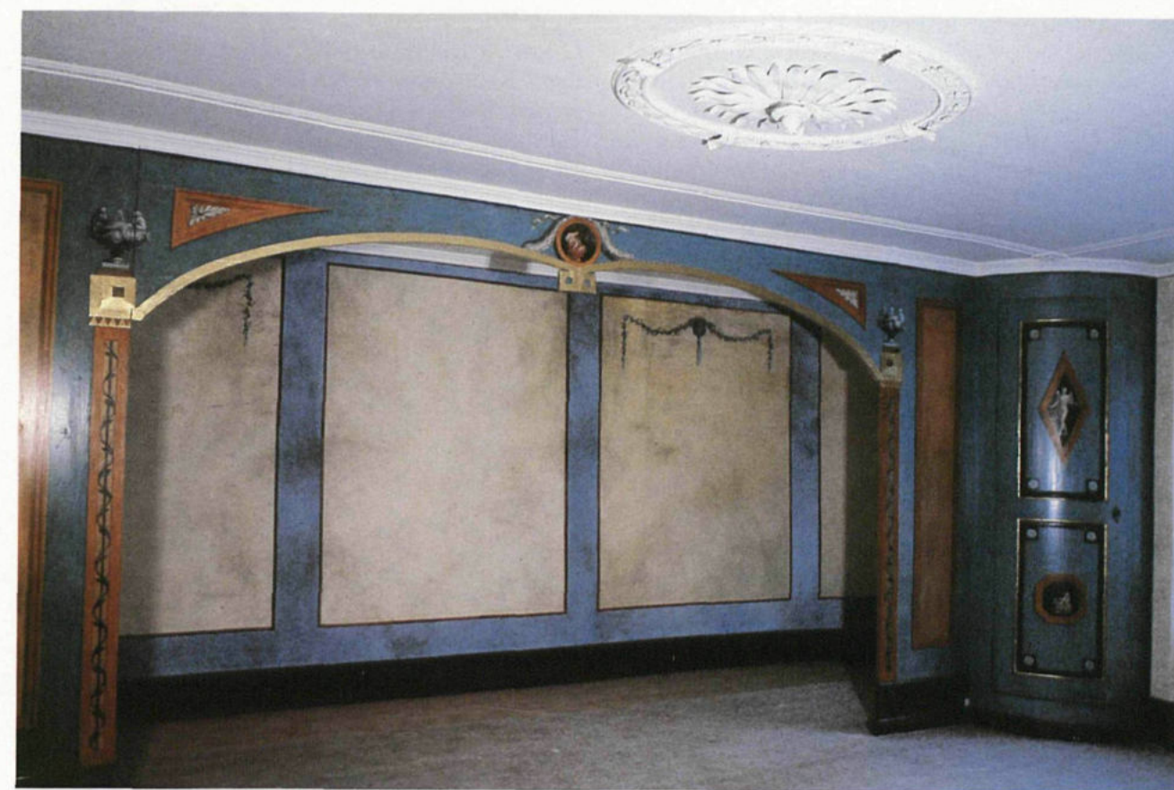
Blick auf den Alkoven, Westwand des Nordzimmers im dritten Stock. Zustand nach der Restaurierung. Foto: Kantonale Denkmalpflege Zug
