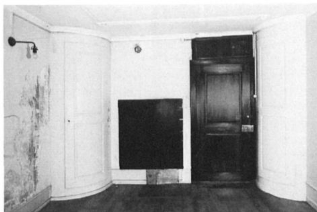
Südwall im Nordzimmer des dritten Stocks. Alte Eingangstüre und Blechverkleidung eines ehemaligen jüngeren Ofens, flankiert von runden Eckkästen. Zustand vor der Restaurierung.
