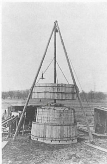
Bau des ersten Grundwasser- pumpwerks im Göbli, 1924
